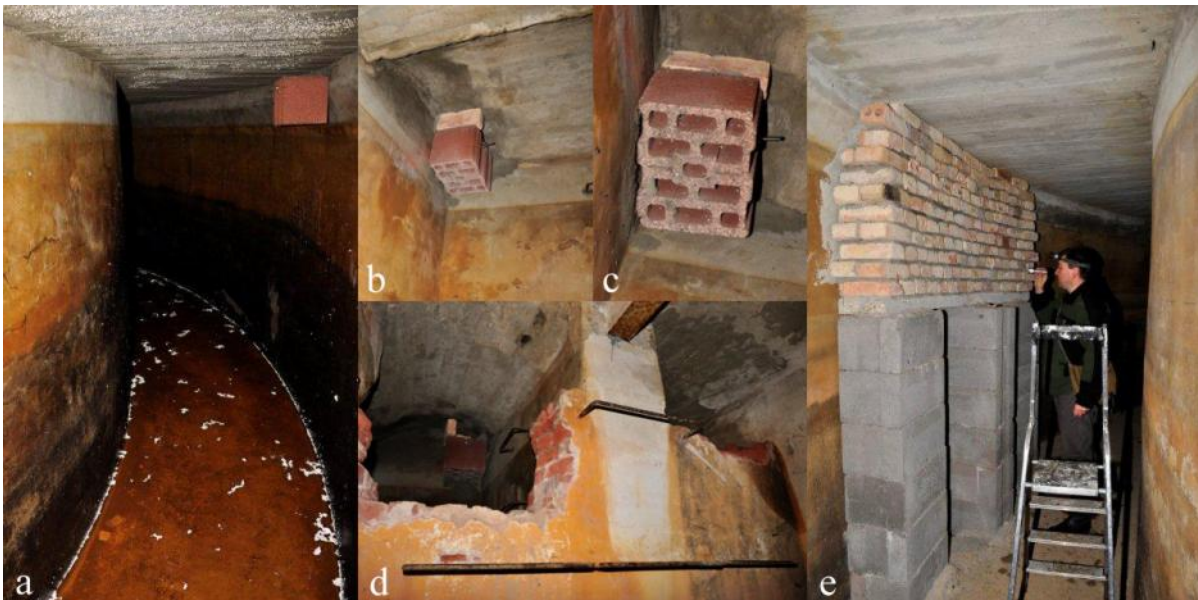
Abbildung 2 - Innenansichten des Fledermausquartiers Comthurey: a) Gang mit Hohlblockstein, b) Hohlblockstein, c) Detailansicht Hohlblockstein, d) Innenansicht, e) gemauerte spaltenreiche Wand (mit Verfasser). Fotos: A. Griesau.
