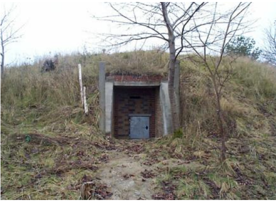
Abbildung 1 - Eingangsbereich des Fledermausquartiers Comthurey. Foto: R. Simon
